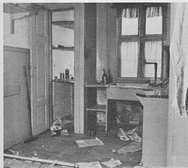
Køkkenet på 2. sal før ombygningen
