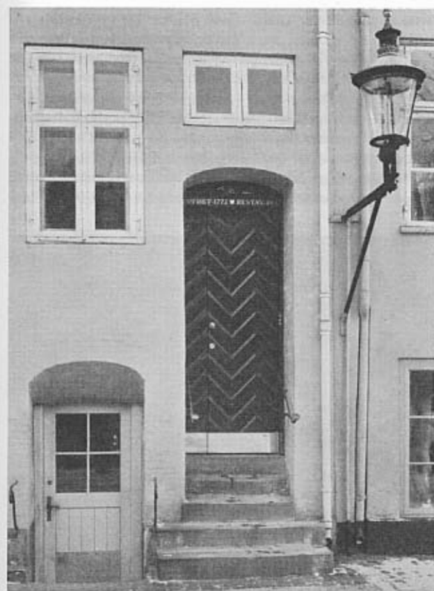
Partiet omkring gadedøren efter restaureringen. Stikket over døråbningen fra 1772 er „genåbnet“ og dørflojen udført med den gamle gadedør (der i forskåret tilstand var anbragt i gårdsiden) som forbillede
