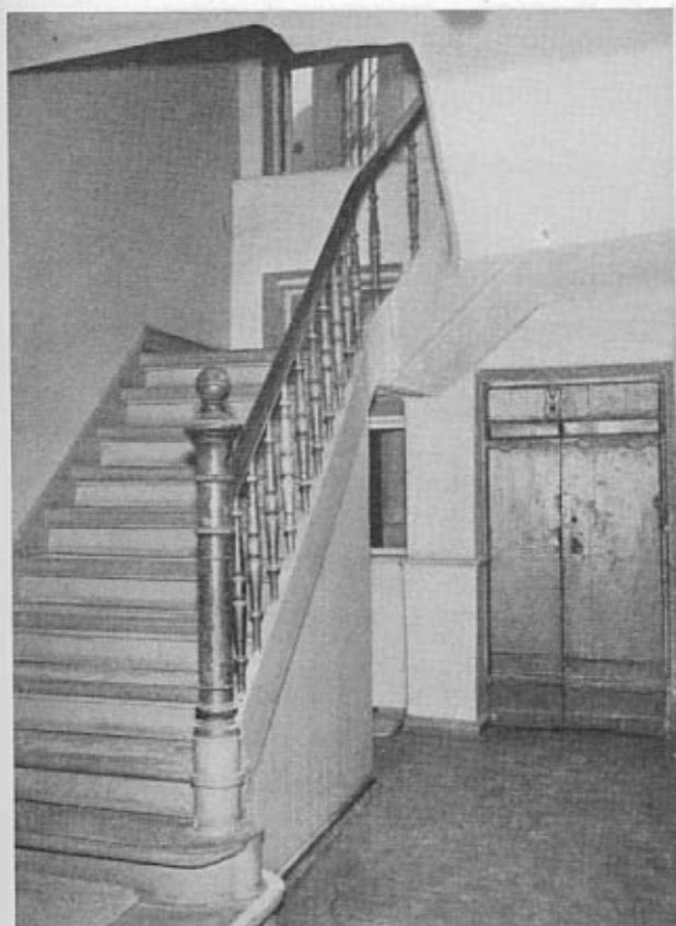
Den eksisterende trappe var både æstetisk og konstruktivt noget makværk, som formentlig skyldes en ombygning kort før århundredskiftet
