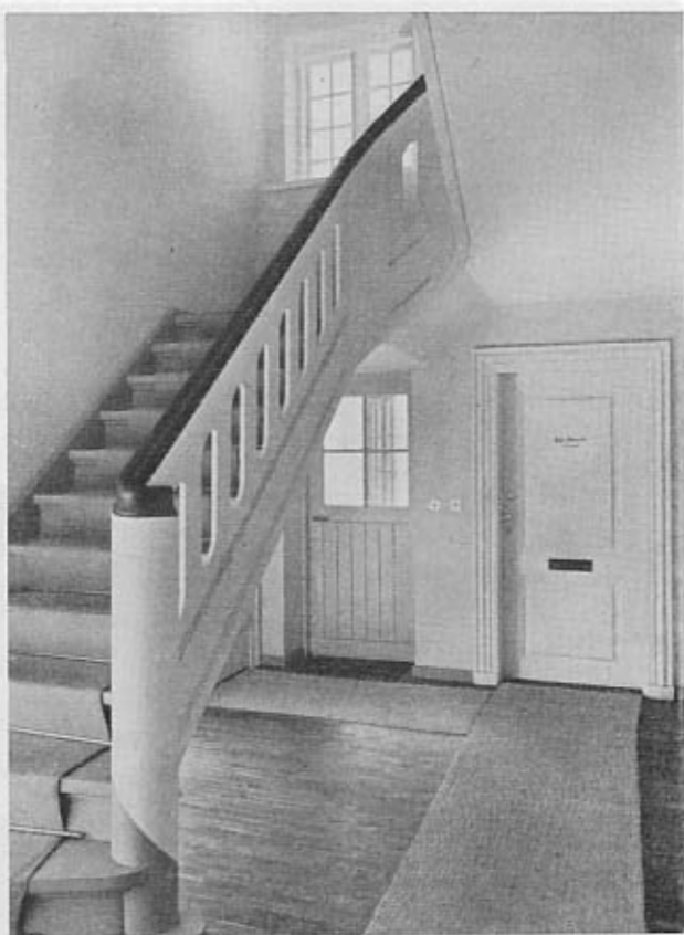
Ved restaureringen blev opsat en helt ny trappe, hvis udformning er inspireret af borgerlige københavnske trapper fra tiden omkring 1770
