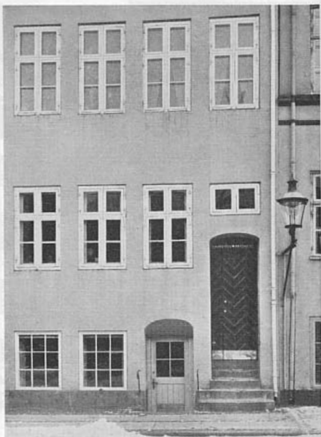
Façadeudsnit efter restaureringen. Vinduesformerne fra 1846 bibeholdt, idet den fjernede tværsprosse er genindsat
